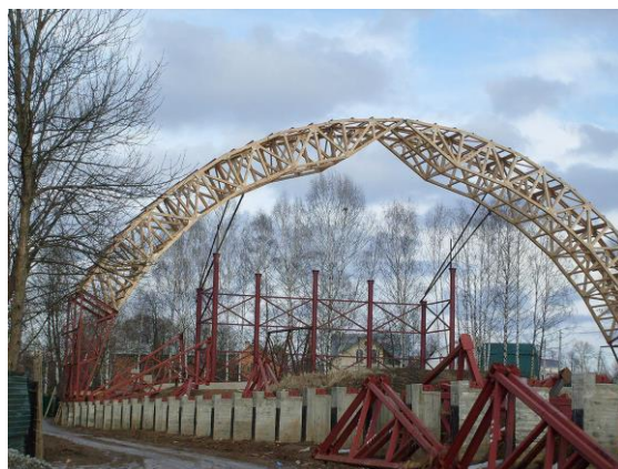
Рисунок 7.4 – Арка из фермы ( l=30...60 м, f=1/3...1/2 )
