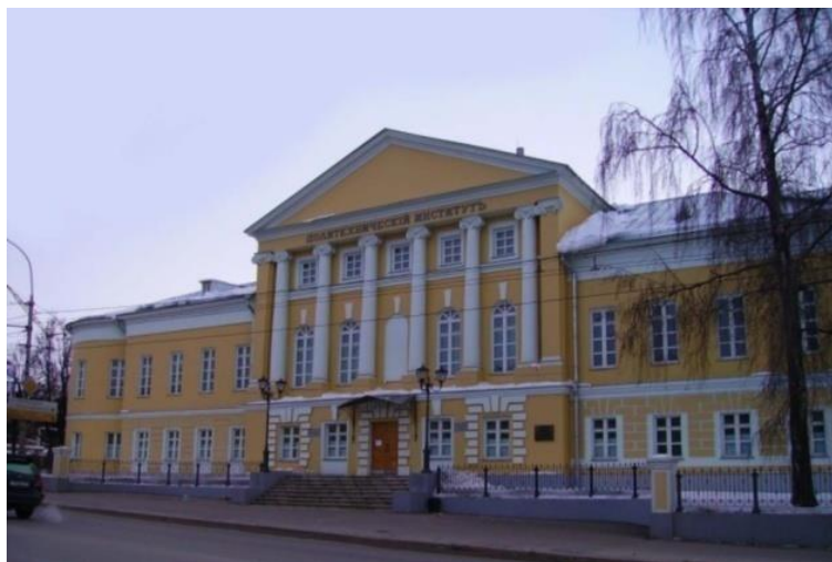
Рисунок 6 - Рязанский институт Московского Политехнического университета
