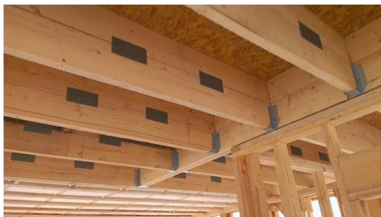
Рисунок 5.7 – Составная балка конструкции В. С. Деревягина
