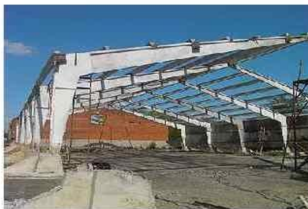
Рисунок 7.1 – Трехшарнирная статически определимая рама
