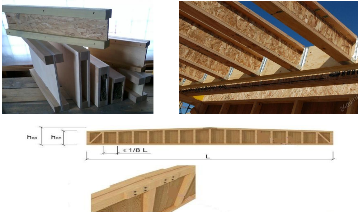
Рисунок 5.14 - Клефанерные балки, общий вид
