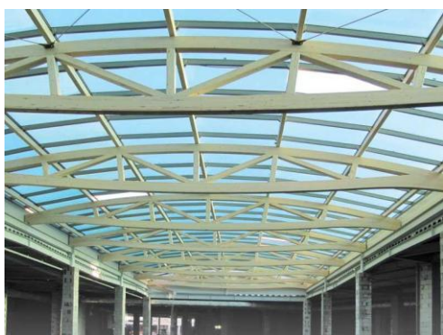
а – линзовидная ферма покрытия, б – общий вид каркаса с фермами покрытия. Рисунок 6.2 – Линзовидная ферма покрытия, общий вид каркаса с фермами покрытия
