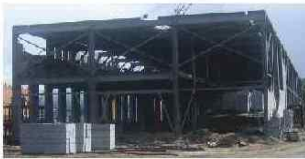
Рисунок 7.2– Двухшарнирная жестко опертая статически неопределимая рама
